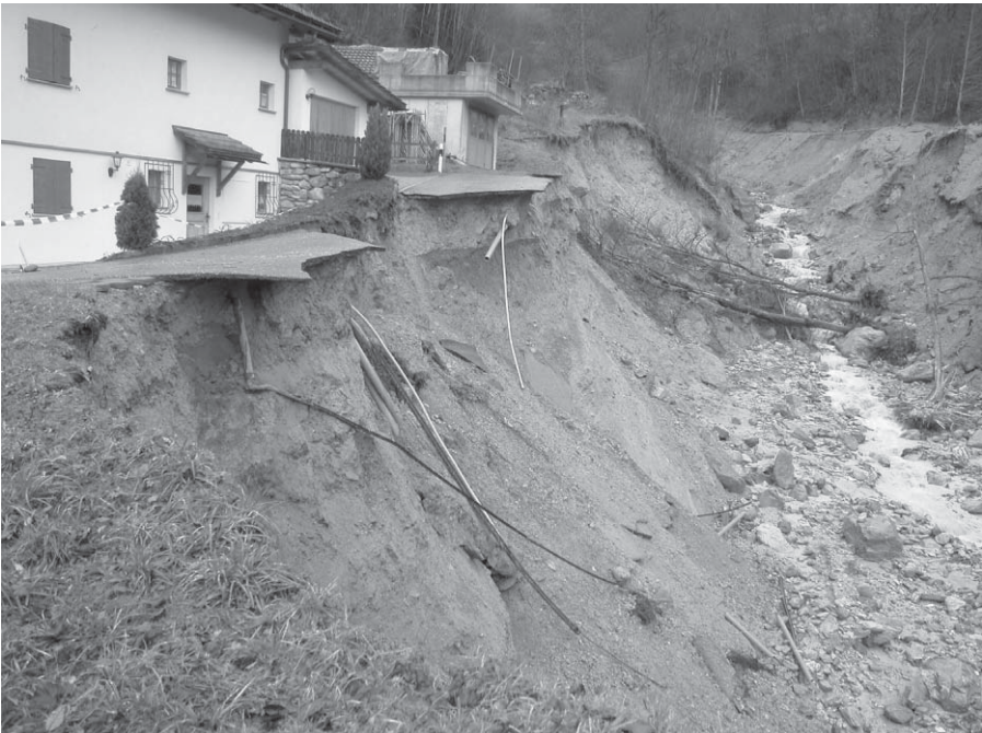
Abb. 6: Im Val Valdun erreicht die Seitenerosion im Dorfbereich etwa 7 m. Zerstörte Zufahrtswege und geborstene Leitungen sind die Folge.
