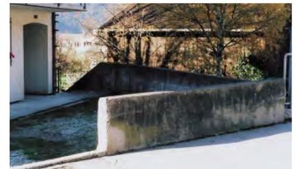
Dabei sind die Fliesshöhe des Murganges zu berücksichtigen, sowie die Anzahl möglicher Murenschübe pro Ereignis. Wird der Keil in Form von Flügelmauern seitlich des Objektes verlängert, so sind keine weiteren Objektschutzmassnahmen am Objekt vorzunehmen. Ansonsten sind die üblichen Einwirkungen aus Druck und Reibung für die Seitenwände zu berücksichtigen.
