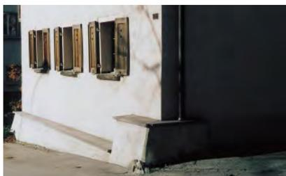
Die gefährdeten Aussenwände sind nach dem wirkenden Druck und der Reibung des Murganges zu bemessen. Dies erfordert in der Regel eine Verstärkung dieser Aussen-
