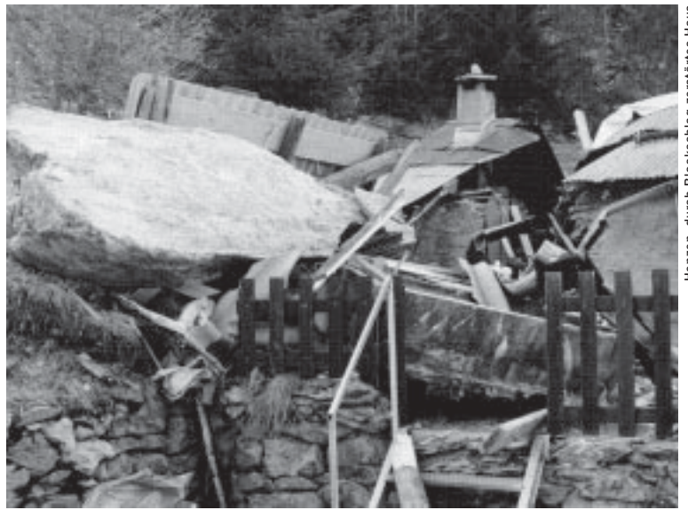
Henzen, durch Blockschlag zerstörtes Haus
