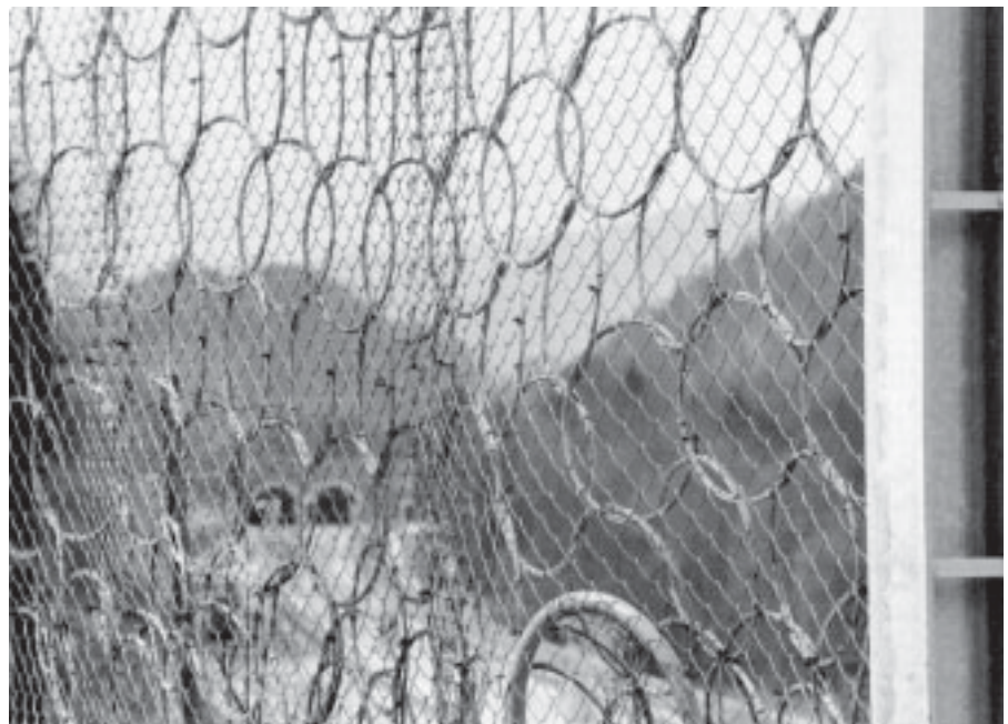
Kellerhals + Haefeli AG, Steinschlagnetz
