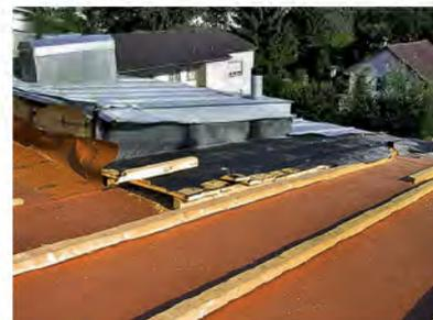
Die Verwendung von Nägeln mit glatter Oberfläche anstelle von Schrauben oder zumindest Rillen- oder Schraubennägeln führte bei diesem Blechfalzdach zum Totalschaden. Die Verbindungen zwischen Dachhaut und Schalung, zwischen Schalung und Konterlat-
