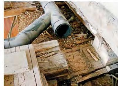
*Schwächung des Tragwerks durch entfernten Balken.*
