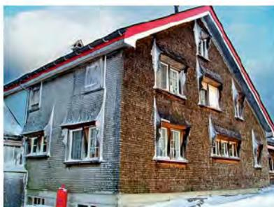
Beispiel eines zur Hauptwindrichtung (Giebel) parallel ausgerichteten Gebäudes. Die windzugewandte Front (linkes Bild) weist einen kurzen Dachvorsprung
