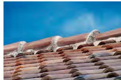
Sturmklammern, Verschraubungen, Vermörtelungen, Ortgangziegel und Randverschaltungen schützen die gefährdeten Bereiche gegen Sogkräfte. Diese Aufzählung ist nicht abschliessend. Neue innovative Lösungen zur Handhabung der Sogkräfte sind denkbar.
