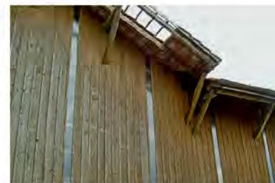
Vordächer ohne Deckunterlage sind der Sogbeanspruchung schon bei geringeren Windgeschwindigkeiten nicht gewachsen.
