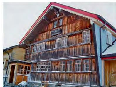
und Fenstervorbauten auf während die windabgewandte Seite (rechtes Bild) einen längeren Dachvorsprung und seitliche Wandverlängerungen aufweist.
