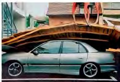
Dieses Dach eines Neubaus wurde infolge einer unzureichenden Befestigung zwischen Konterlatten und Sparrenpfetten abgehoben und auf den Vorplatz geworfen (Personengefährdung!).
