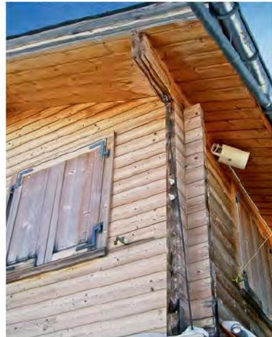
kräfte, welche am Dachvorsprung angreifen, in das Fundament abgeleitet.
