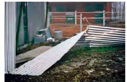
*Die offene Deckunterlage führte zu einer Überlagerung von Innendruck und äusserem Windsog. Das Dach hielt dem nicht stand.*
