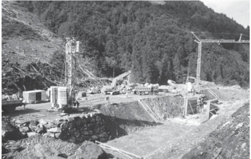
Abb. 6.35: Baustelle Tagbautunnel an der Verbindungsstrasse Muota ins Bisistal wo die Lawine vom Geisstock die Kantonsstrasse kreuzt. Nach einem grossen, in diesem Ausmass seltenen Lawinenabgang auf die Strasse wird ein 260 m langer Tagbautunnel erstellt. Der Tunnel wurde 2000 fertiggestellt. Die übrigen, weniger heiklen Lawinen wurden nicht durch bauliche Massnahmen gesichert, wodurch die Strasse bei heiklen Situationen weiterhin gesperrt werden muss. Foto: SLF/S. Margreth, Juli 1999.
