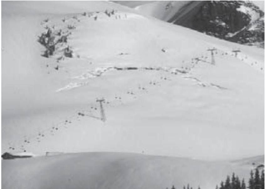
Abb. 4.52: Sessellift im Skigebiet von Hasliberg nach Ende des Schneegleitens. Eine Grundlawine hat sich sehr langsam gelöst und die Skiliftstütze des fahrenden Sessellifts umgelegt. Die Personen am Sessellift wurden per Helikopter evakuiert, noch bevor die Stütze am Boden lag. Foto: SLF/S. Margreth, 15.3.1999.
