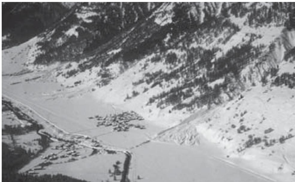
Abb. 6.45: Der Leitdamm in Ulrichen, VS zeigte gute Schutzwirkung gegenüber einer vermutlich nicht sehr schnellen Lawine (vergleiche auch: SLF 2000 A. 4.149, Seite 460). Foto: SLF/S. Margreth, 26.2.1999.
