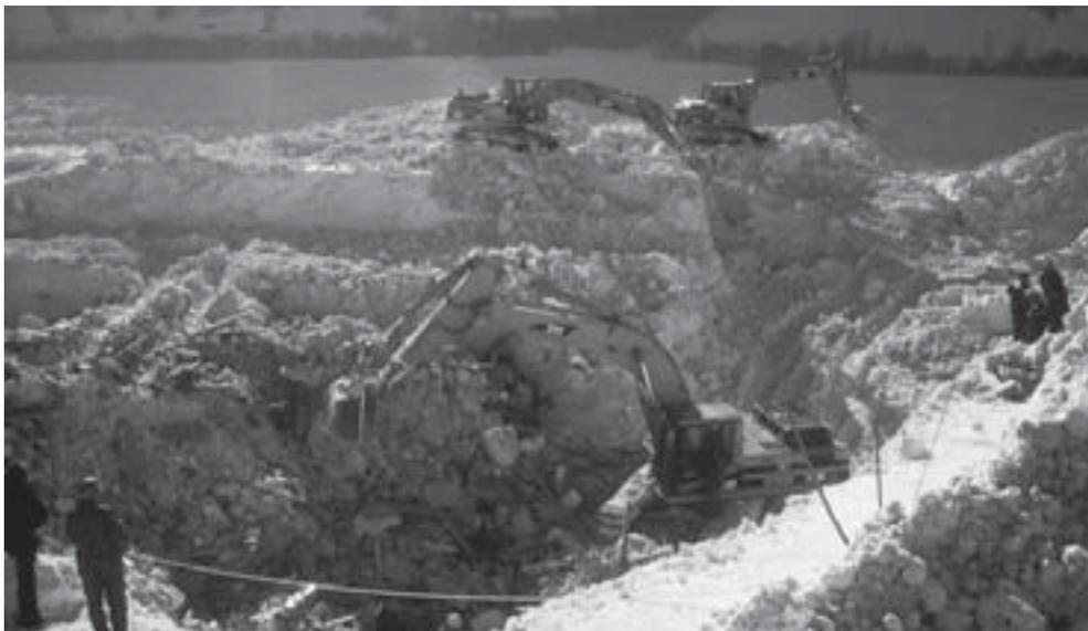
Abb. 6.51: Grosse Raupenbagger erhöhen am 27.2. den Lawinenablenkdammbau in Geschinen, VS, um weitere Schäden durch abgehende Lawinen zu verhindern, was auch gelang. Das unter 10 m Nassschnee verschüttete Haus wurde bereits in der Nacht vom 26. auf den 27.2. so weit freigelegt, dass der Tote aus seinem Haus geborgen werden konnte. Foto: Lawinenwarndienst Goms, 27.2.1999.
