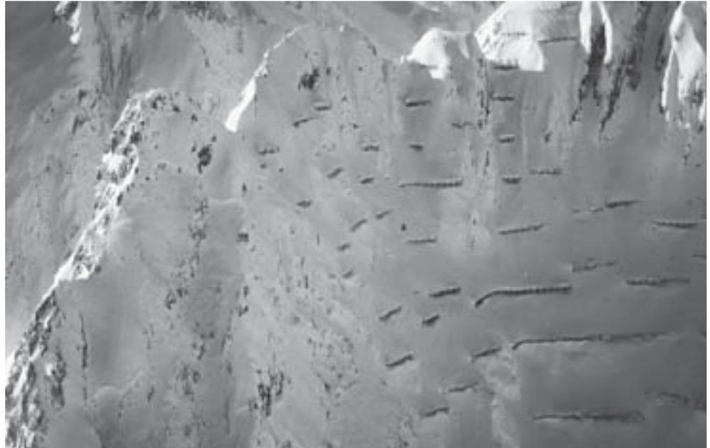
Abb. 6.24: Übersicht der Lawinerverbauung am Geissberg ob Gurtellen. Die Werke sind fast eingeschneit. Foto: SLF/S. Margreth, 26.2.1999.
