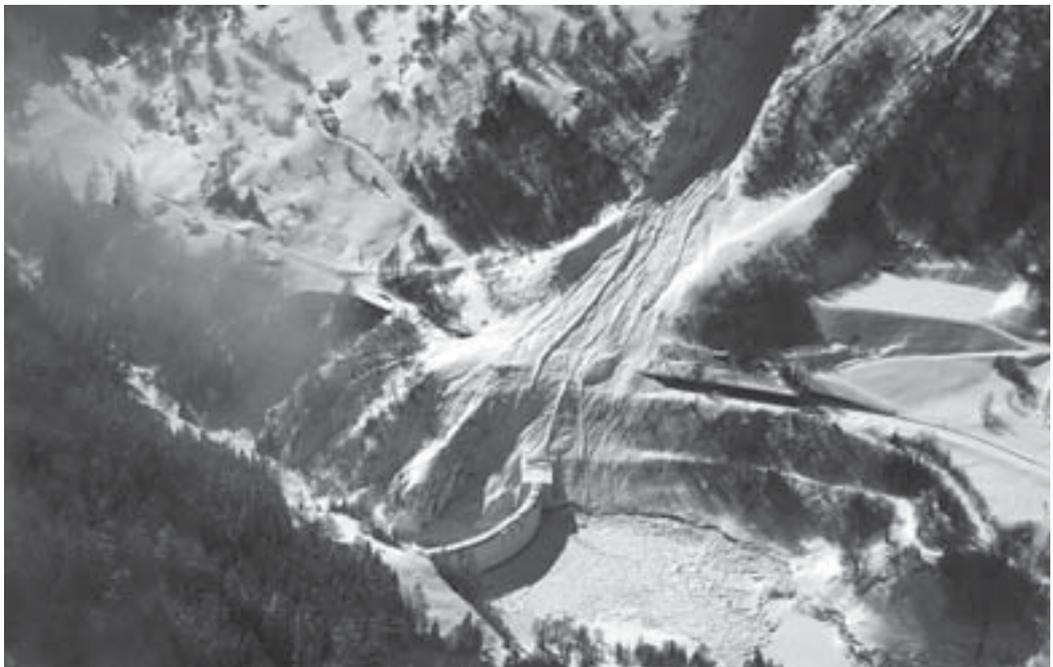
Abb. 6.58: Die Faldumbachlawine beschädigt das Betriebsgebäude bei der Staumauer in Ferden, Lötschental. Die 37 m hohe Bogenmauer erlitt keine strukturellen Schäden, aber die sich auf der Luftseite befindlichen Nebengebäude (im Bild nicht sichtbar) wurden von der Lawine teilweise zerstört und der Grundablass wurde verschüttet und musste freigelegt werden. Foto: SLF / S. Margreth, 25.2.1999.
