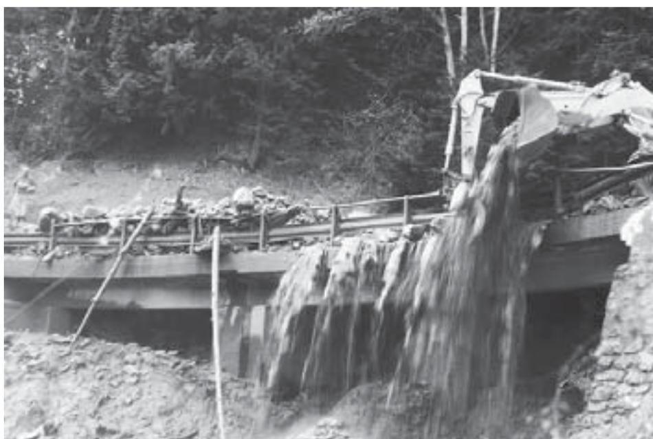
Abb 4.58: Hexentobel, Gemeinde Klosters-Serneus, GR, am 21.5. 1999. Grosse Niederschläge führten zu einem Murgang, der die Strassen- und Bahnverbindung ins obere Prättigau unterbrach. Foto: SLF/M. Bründl, 21. 5. 1999.
