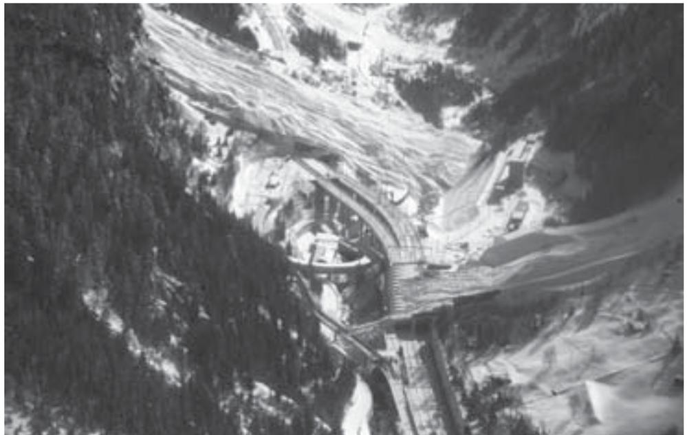
Abb. 6.60: Meiggbach (Lawine von rechts) und Rotlaugalerien (Lawine kommt von links) bei Goppenstein, VS, die im Februar 1999 mehrfach Grosslawinen über die BLS-Eisenbahnlinie und die Kantonsstrasse geleitet haben. Foto: SLF/S. Margreth, 25.2.1999.
