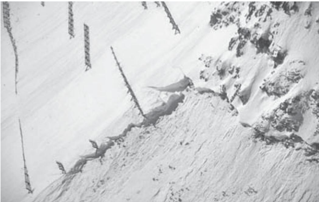
Abb. 6.72: Detail des Lawinenanbruchs neben der Lawinenstützverbauung Schweifinen, Zermatt, VS. Die verstärkten Bauwerkenden und die zwischen den Werkreihen eingebauten Einzelwerke haben sich bewährt. Foto: SLF/S. Margreth, 25.2.1999 (vergleiche auch Abb. 4.125 in SLF 2000).
