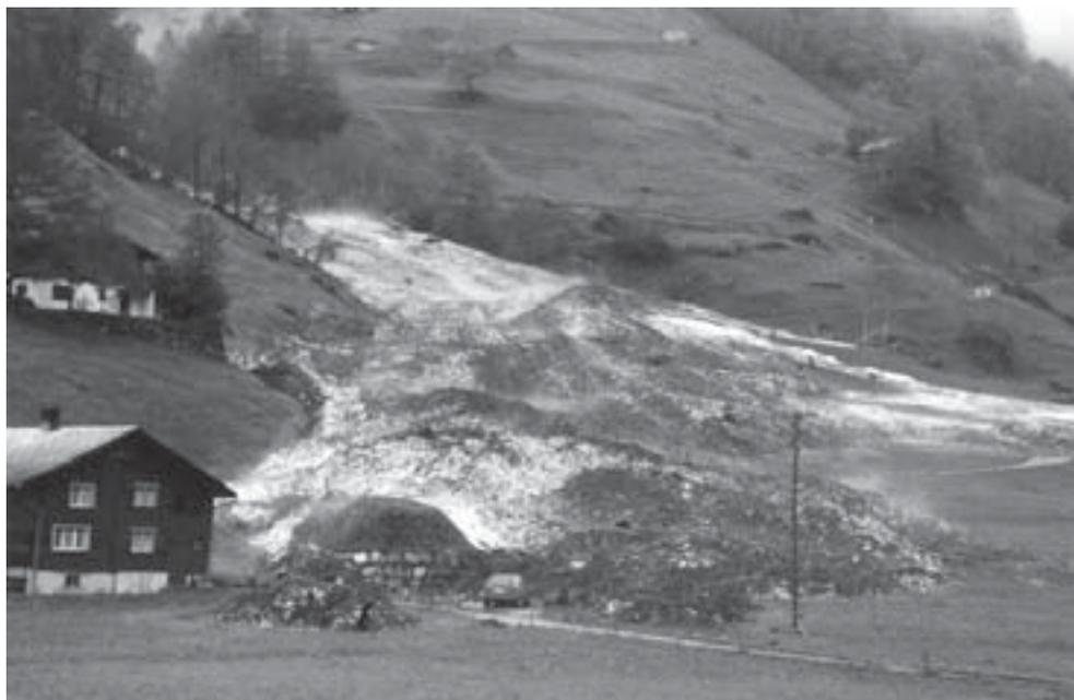
Abb. 6.28: Grosses Aufräumen rund um die Chüebodenlawine, Elm, GL im Frühjahr. Der Ablenkdammschützte das Gebäude links unten vor vier Abgängen. Foto: SLF / R. Meister, 12. 5. 1999.
