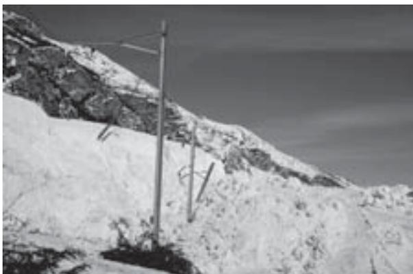
Abb. 6.19: Zerstörte Fahrleitungen der Furka-Oberalpbahn am Oberalppass. Foto Archiv SLF.
