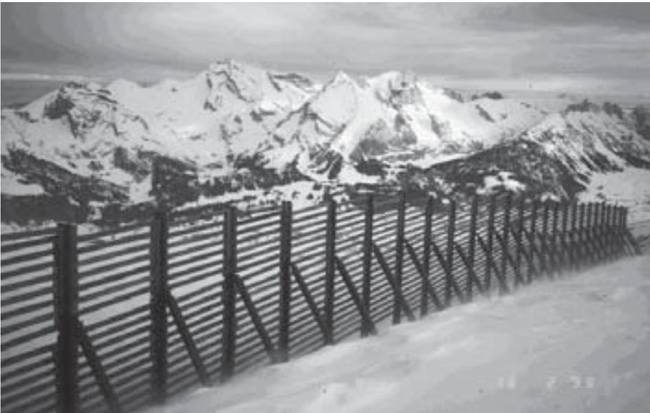
Abb. 4.20: Verwehungszaun am Hinderrugg-Churfirsten, der Schneeeinwehungen in das Einzugsgebiet der Schattenbachlawine ob Walenstadt verringert. Die Schattenbachlawine wurde mit dem 12 cm-Mienenwerfer 10 Mal künstlich ausgelöst, so dass keine grosse, Schaden bringende Lawine spontan abgehen konnte. (vergleiche SLF 2000, Seite 474–477) Foto: SLF/T. Wiesinger, 16. 2. 1999.
