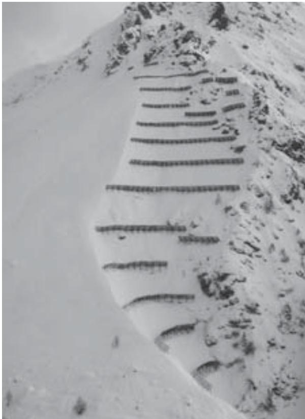
Abb. 4.60: Lawinenstützverbauungen Cozz-Balnisc im Misox, die die A13 vor Lawinen schützt. Die Verbauung ist kaum mit Schnee gefüllt, was Ausdruck der Schneearmut im Süden und der Jahreszeit ist. Foto: Kantonales Tiefbauamt GR, S. Fehler, 30.5.1999.
