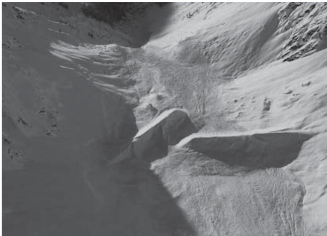
Abb. 6.53: Detail der Auffangdämme im Bächtital oberhalb von Reckingen, VS. Das aufgefangene Schneevolumen ist relativ klein. Die steile Ablagerungsform bergseitig lässt auf eine schnelle Lawine schliessen. Der Leitdamm in Reckingen im Tal zeigte eine gute Wirkung. Foto: SLF/S.Margreth, 26.2.1999 (vergleiche auch SLF 2000, Abb 4.146 auf Seite 458 und Abb. 4.148 auf Seite 459).
