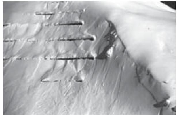
Abb. 6.85: Lockerschneelawinen in der gefüllten Verbauung Chüenihorn, unterhalb vom Bärgli (2100 m, Exposition Südwest), St. Antönien, GR am 25.2.1999. Foto: SLF/T. Russi.
