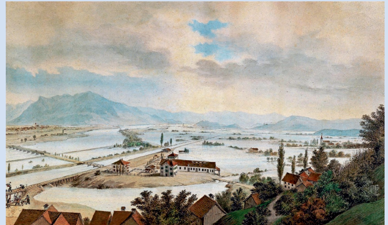
Abb. 28: Die Überschwemmung von 1868 bei Au (SG) 1 (Aquarell). Ganz links wird die beschädigte Bahnbrücke wiederhergestellt. Das als sehr zuverlässig und zeitgenössisch einzustufende Bild kann deutlich besser als jede schriftliche Quelle das Ausmass der Überschwemmungen im Rheintal veranschaulichen, insbesondere, wenn sie mit Detailaufnahmen, etwa der frühen Fotografie aus Lustenau (Abb. 1, auf dem Aquarell links im Hintergrund), kombiniert werden. Allerdings bleibt unklar, ob das Bild den Höchstwasserstand wiedergibt oder – aufgrund der schon einsetzenden Reparaturarbeiten – wohl eher einen bereits sinkenden Wasserstand.
