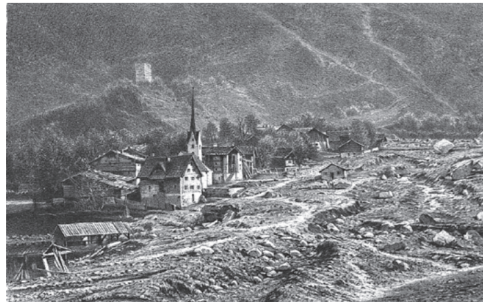
Abb. 54: Hochwasser und Murgänge in Zignau 1868 (links) 35 und 1987 (rechts).
