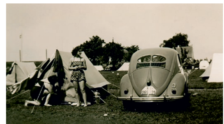
Abb. 71: Zeitgleich mit dem Aufschwung der 1950er Jahre rückten Hochwasser in den Hintergrund. Ein neuer Lebensstil kam auf. Stellvertretend dafür zeigt das Bild einen Campingplatz. Oft wurden diese auf hochwassergefährdeten Flächen errichtet.
