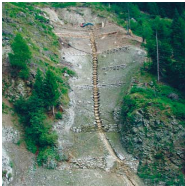
Rutschverbauung mit Holzkästen und Entwässerungsrinnen (Varunela, Poschiavo).
