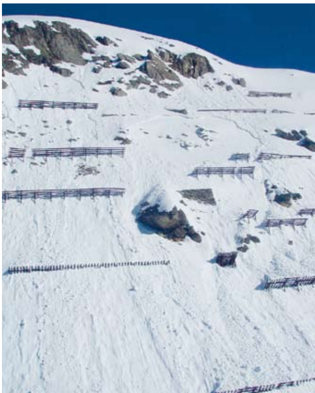
Ungenügender Schutz: Lawinenanriss innerhalb einer Verbauung.
