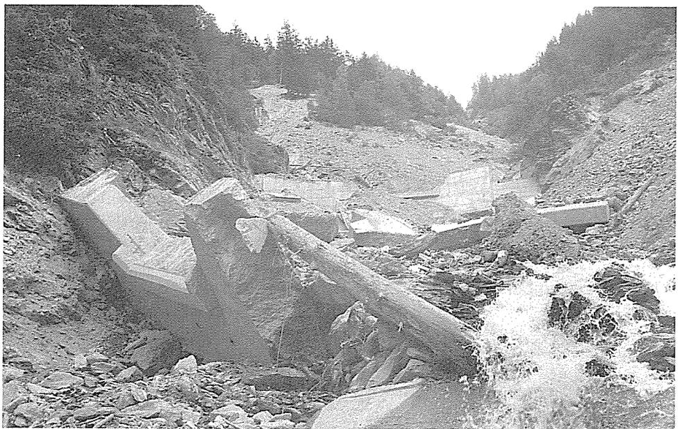
Abb. 84. Pfingstunwetter 1983: Durch Murgänge zerstörte Bachverbauung im Münstertal (GR). Foto: G. Röthlisberger, WSL.
