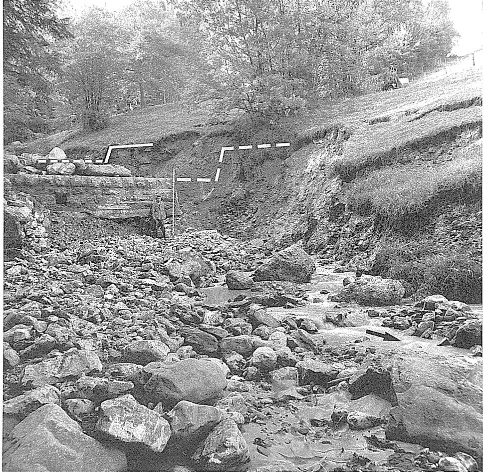
Abb. 82. Das Unwetter vom 1. bis 2. Juni 1979 in Hergiswil (NW). Im Bild eine gebrochene Sperre von 1,2 m Nutzhöhe. Die beiden untenliegenden Sperren wurden zerstört. Infolge Erosion hat sich das Bachbett um rund 1,6 m vertieft und linksufrig stark verbreitert. Foto: G. Röthlisberger, WSL.
