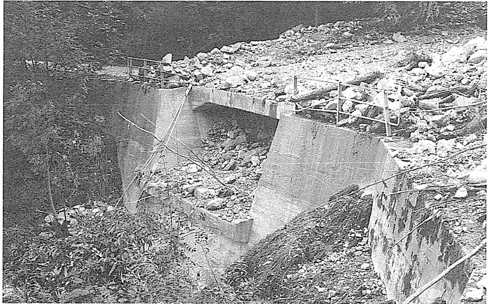
Abb. 83. Die Buochser Rübi bei Buochs (NW) nach dem Unwetter vom 16. bis 17. August 1981. Das Bild zeigt eine Strassenbrücke, verstopft und von Geschiebe überfahren. Foto: A. Böll, WSL.
