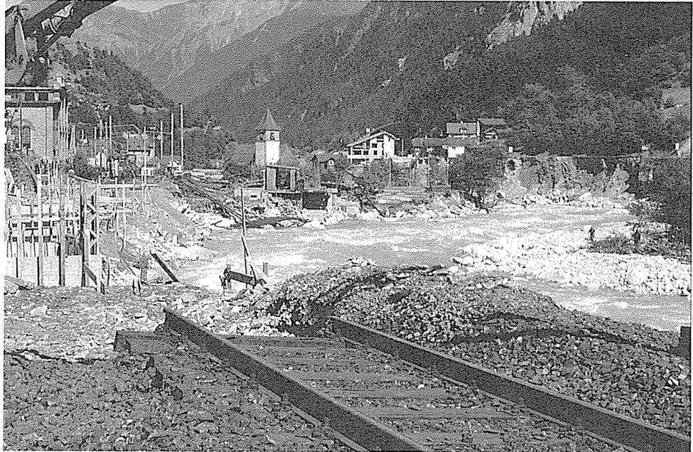
Abb. 96. 24. bis 25. August 1987 bei Gurtellen (UR). Die Reuss spülte das Trasse der Gotthardbahn weg; die internationale Linie wurde während 18 Tagen völlig unterbrochen. Foto: Schweiz. Rückversicherungs-Gesellschaft, Zürich.
