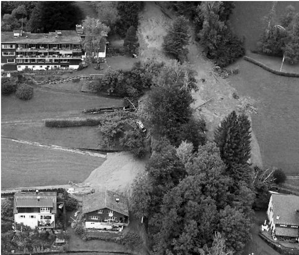
Fig. 4: Hangmure, aus der sich ein murgangartiger Abfluss durch das Siedlungsgebiet von Unterägeri ZG entwickelte. Der Abfluss und die Mobilisation weiteren Materials wurden durch das Bersten eines Wasserreservoirs stark erhöht (Foto: Kantonsforstamt Zug).
