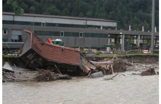
Abb. 5: In diesem Fall war die Erosionstiefe so hoch, dass das Gebäude einstürzte.
