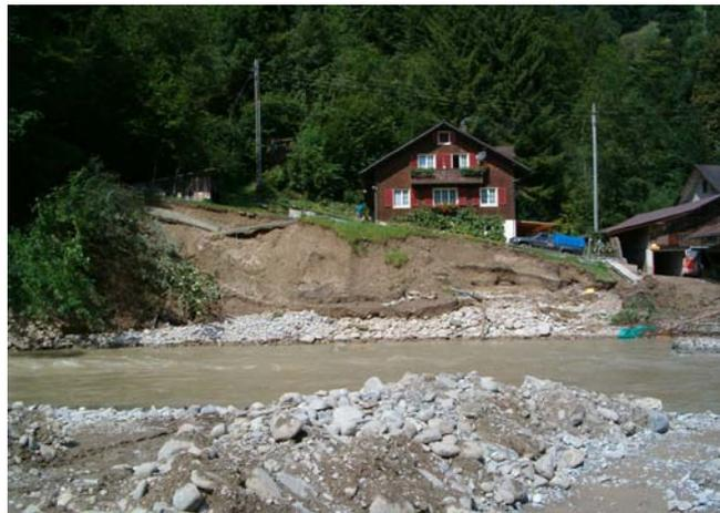
*Abb. 2: Bei langen, geneigten Uferböschungen geht die Ufererosion oft fliessend in Uferferrutschung über. Die Methodik erfasst die Uferferrutschungen nicht korrekt.*
