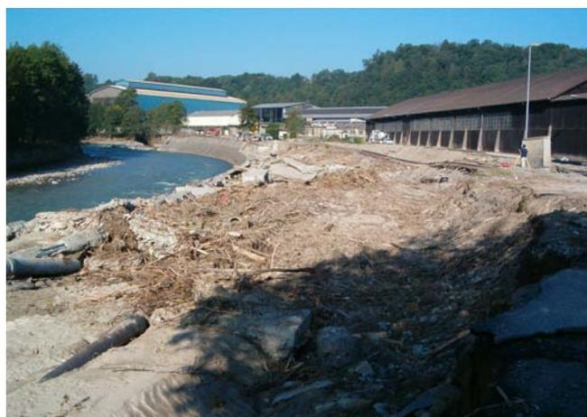
*Abb. 3: Ufererosionen treten immer wieder hinter resp. neben Verbauungen auf. Dabei sind hydraulische Belastungen massgebend, die hoch am Ufer oder im Überflutungstreifen direkt neben dem Gerinne angreifen.*
