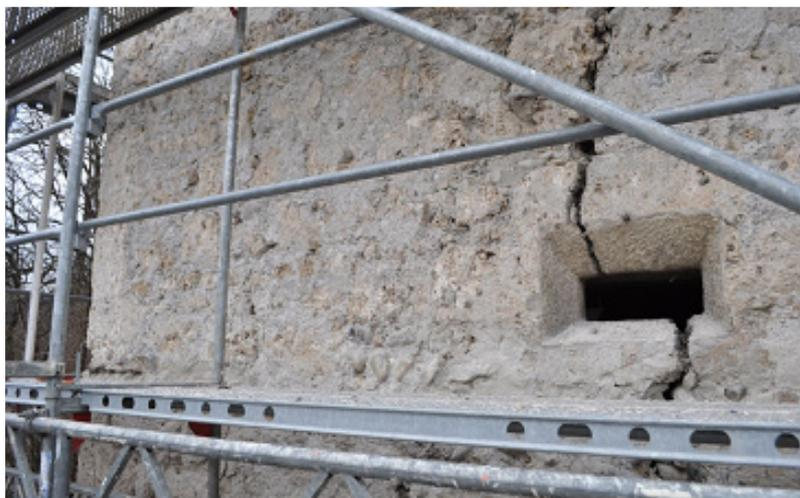
Abb. 4: Die Geländekante unter diesem Haus hat sich deutlich abgesenkt. Der Einflussbereich 'b' ist jedoch kleiner als 5 m. Das Haus ist eindeutig einsturzgefährdet
