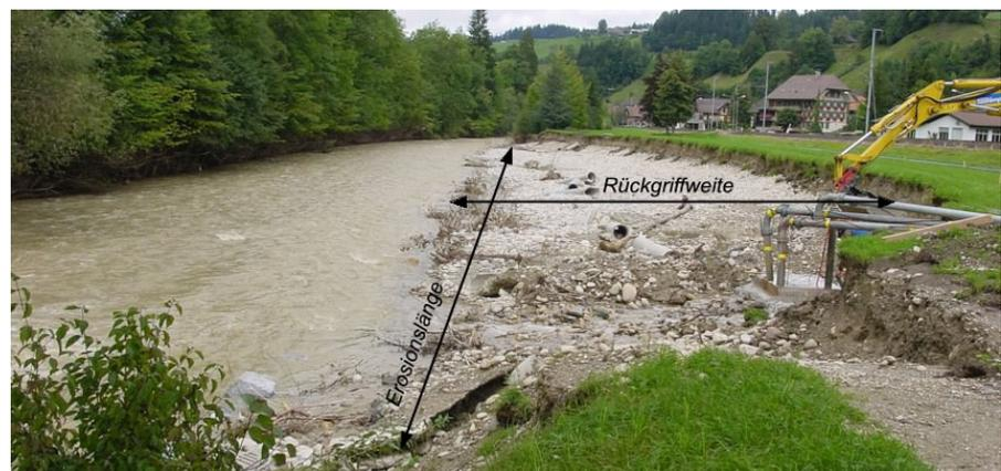
Abb. 5: Seitenerosion an der Ilfis. Definition von Erosionslänge und Rückgriffweite. Bildquelle: Flussbau AG SAH.
