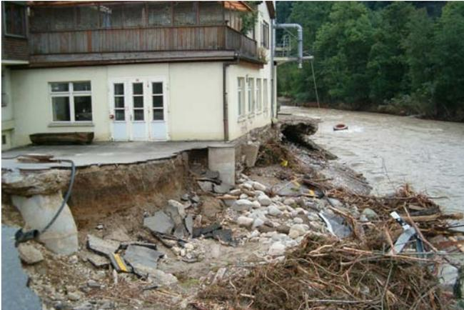
Abb. 4: Die Einsturzgefahr eines Gebäudes hängt von der Abtragshöhe (Erosionstiefe) ab. Die Rückgreiftiefe begrenzt den Wirkungsraum des Gefahrenprozesses.
