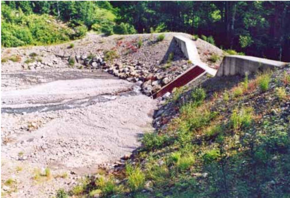
Abb. 4.7: Rechensperre (Schlitzsperre mit vertikalem schrägem Rechen) in der Guppenruns, Schwanden, GL.
