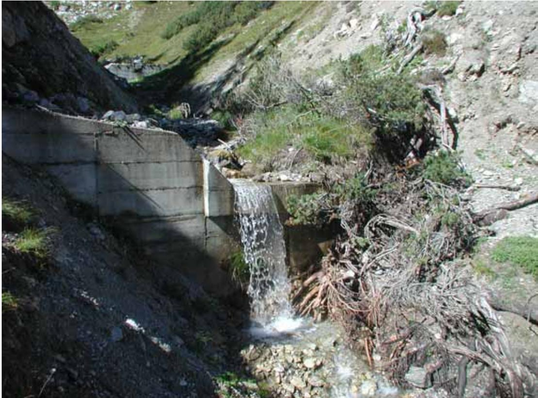
Abb. 3.10: Durch seitliche Einrutschung teilweise verkleaste Abflusssektion (E. Frick, tur gmbh).
