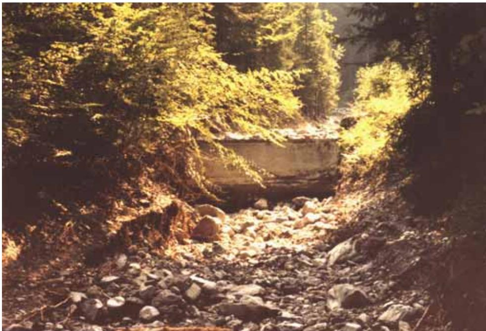
*Abb. 3.9: Gerade Wildbachsperre aus (Stahl?) Beton. Nicht nach den Regeln des Vollverbaus angeordnet. Nach einem Hochwasserabfluss hat sich die Gerinnesohle vor der Sperre auf das Grenzgefälle (wenige Prozent) abgesenkt. Dadurch wurde das Sperrenfundament freigelegt.*
