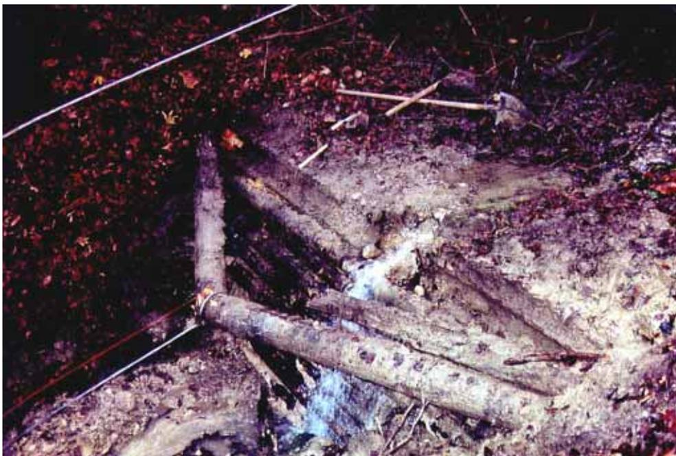
Abb. 3.7: 60-jährige Rundholzsperrre bei Hirzel ZH. Die Sperrentreppe musste erneuert werden und einzelne Sperren wurden bezüglich der Holzfestigkeit untersucht (Noetzli et al., 2002). Die Rundholzlagen sind seitlich in die Flanken eingebunden und tragen somit von Flanke zu Flanke. Sofern die Flanken abrutschen, kollabiert eine solche Sperre. Das gleiche gilt sinngemäss auch für Stahlbetonsperren, welche als Balken oder Platten von Flanke zu Flanke tragen.
