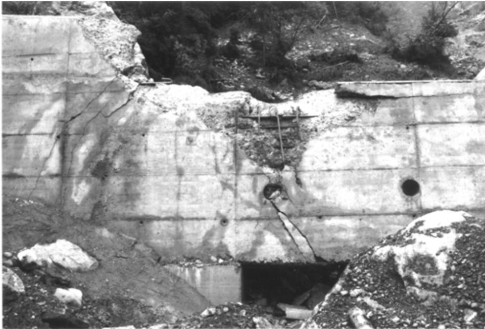
*Abb. 3.8: Wildbachsperre aus Stahlbeton welche im noch nicht hinterfüllten Zustand durch Blockschlag beschädigt wurde. Die Tragsicherheit ist nicht mehr gewährleistet. Die Sperre war dann allerdings noch einige Jahre im Betrieb, bis sie durch Vorbetonieren saniert werden konnte (Aufnahme W. Gerber 1985).*
