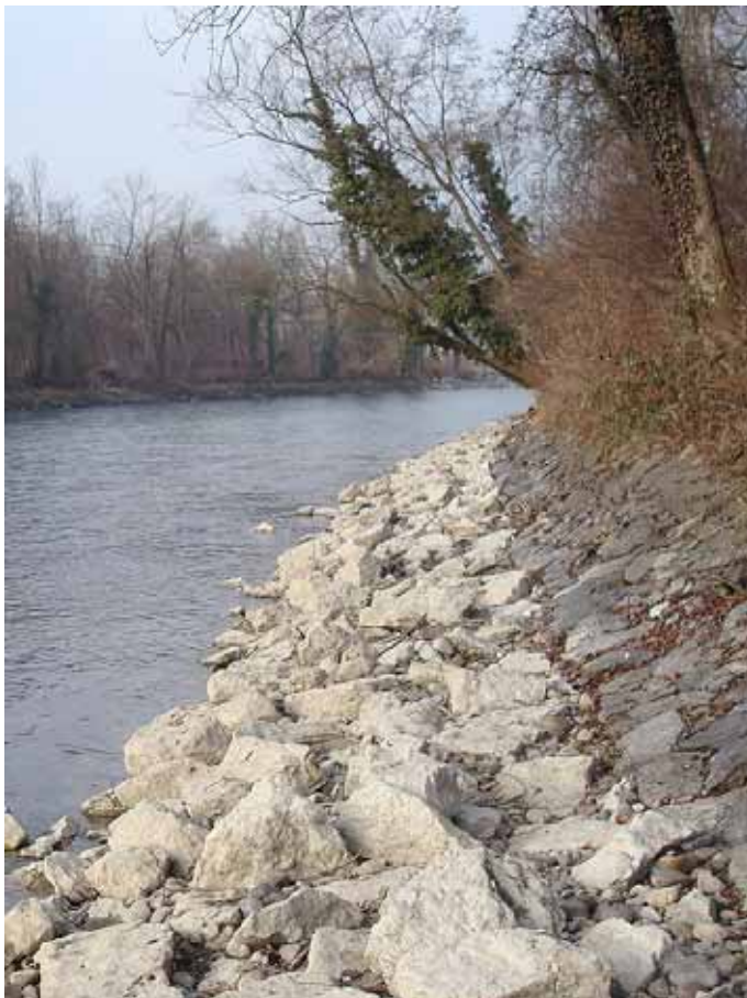
Ufersicherung an der Aare in der Stadt Bern (Flussbau AG SAH)
