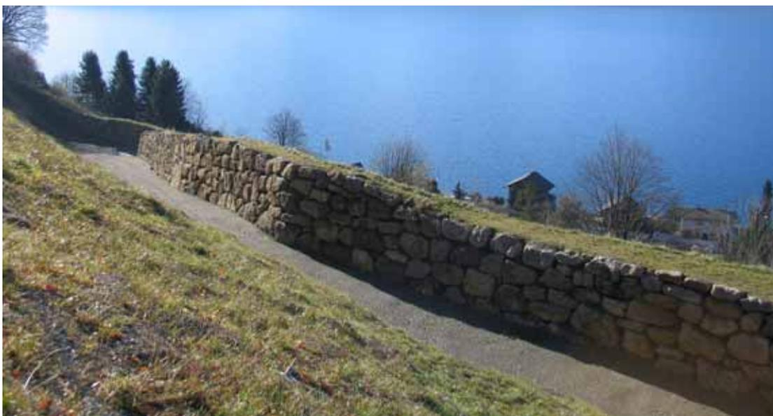
Abb. 8.1: Steinschlagschutzdamm Laugneri Weggis.
