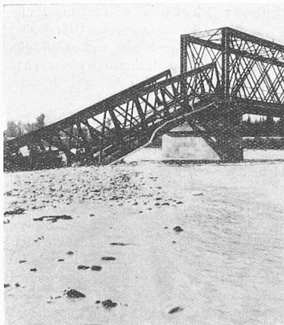
Abb. 10. Landöffnung rechts, nach Ablauf des H.-W. flussaufwärts 4, abwärts 2 von 9 Feldern eingesandet.
