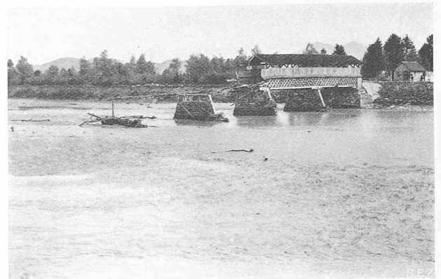
Abb. 7. Die Reste der Brücke am rechten Ufer des entleerten Rheinbettes.
