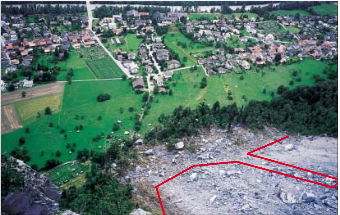
Abb. 4: Nach dem Ereignis. Die rote Linie zeigt die ursprüngliche Waldgrenze. Der Schutzwald ist beinahe vollständig zerstört worden.
