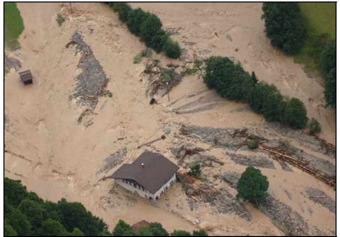
Abb. 2: Durch Wasser, Schwemmholz und Geschiebe stark in Mitleidschaft gezogenes Schulhaus Bündelti (Bild: AfW GR)
