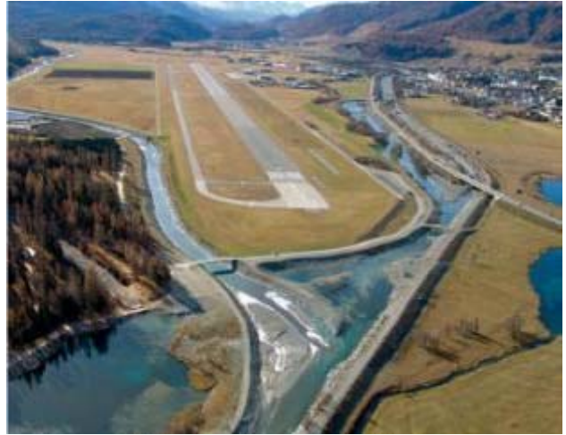
Im heutigen Zustand
